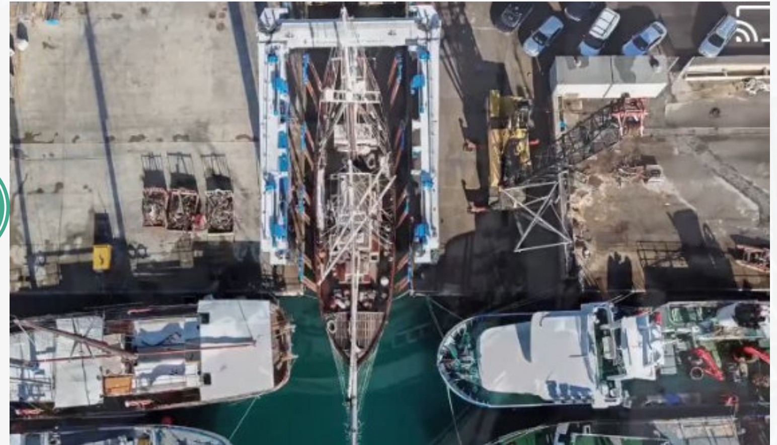
Motoscalo di alaggio e varo di imbarcazioni
