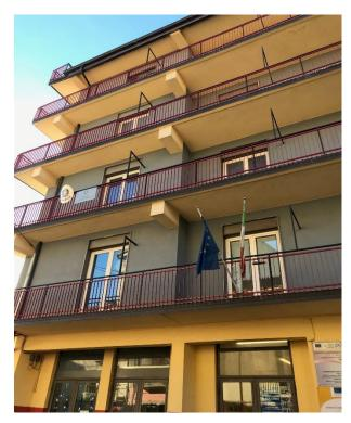
La struttura, da fatiscente, dopo i lavori di ristrutturazione è stata rinnovata sia a livello estetico che a livello strutturale: sono state sostituite e migliorate le ringhiere all'esterno rispettando le norme di sicurezza; gli infissi e le porte esterne sono state modernizzate e anch'esse rese sicure; la struttura è stata imbiancata rispettando anche i canoni esterni della zona. Inoltre sono state aggiunte le strisce pedonali vista la funzione dell'edificio.
